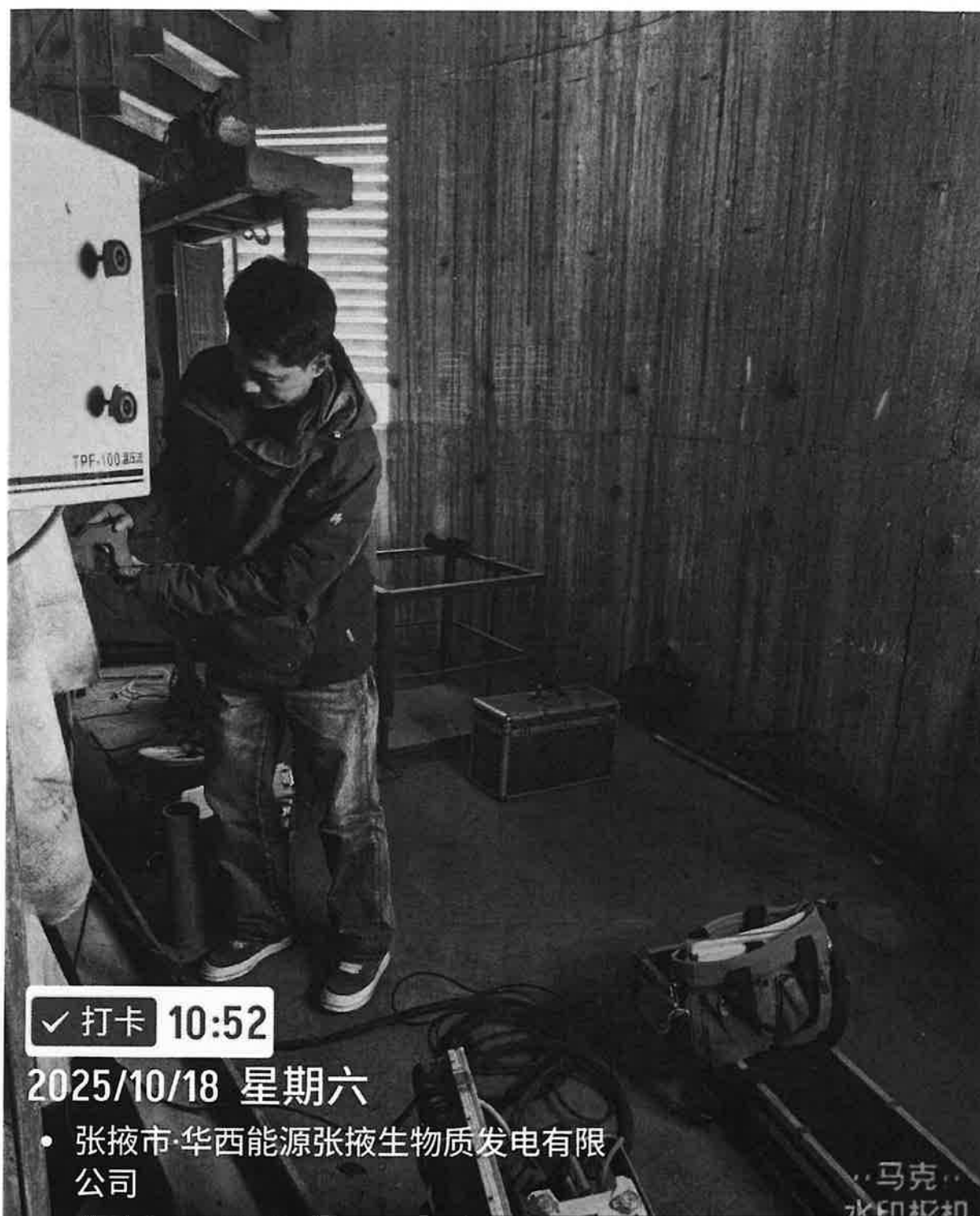
【附图】现场检测照片
